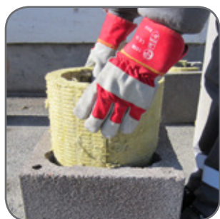
9.6 Meghajlítjuk a szigetelő lapokat, és már előre behelyezzük a következő köpenytéglába.
