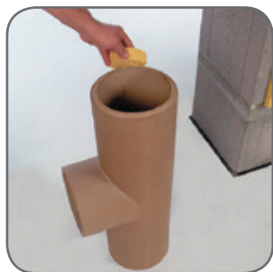
9.2 Megtisztítjuk a füstcső-csatlakozó csővégeit.
