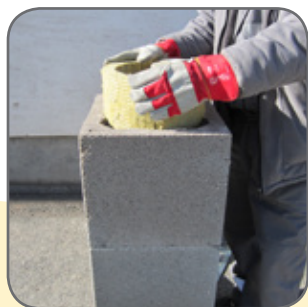
6.2 A szigetelő lapot meghajlítjuk és behelyezzük.
