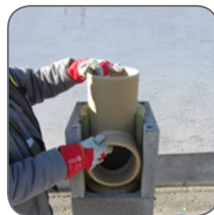
9.4 Behelyezzük a csatlakozót
