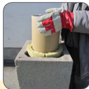
6.4 A samottcsövet behelyezzük és a kinyomódó hézagkittet letöröljük.
