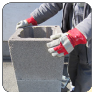
6.1 A köpenytéglát a habarcs-terítésbe helyezzük
